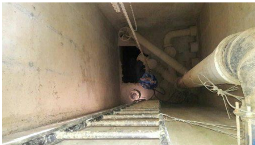
Ilustración 3.7 Torre de galería en su interior instalando equipo de bombeo sumergible.
