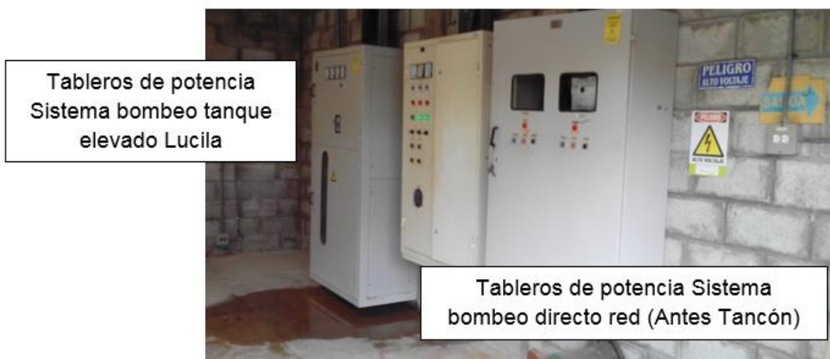
Ilustración 3.51 Tableros de potencia para los sistemas de bombeo Tacón (bombeo directo a la red) y Lucila (Bombeo directo al tanque elevado La Lucila)
