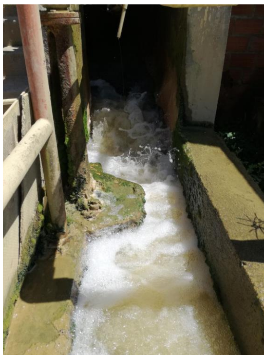
Ilustración 3.32 Punto de aplicación de ayudante para floculación
