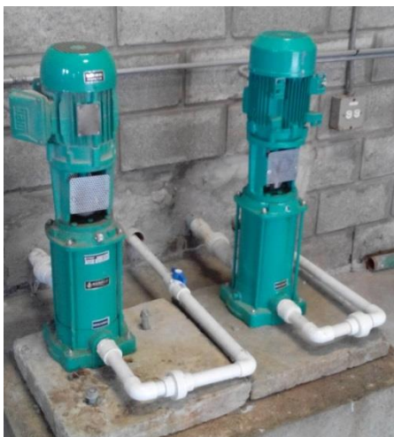
Ilustración 3.44 Motobombas sistema de cloración y tableros de potencia
