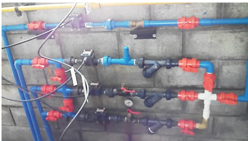
Ilustración 3.45 Accesorios hidráulicos con eyectores, filtros, válvulas, manómetros entre otros accesorios actuales del sistema de cloración al interior de la PPAP Villa María.
