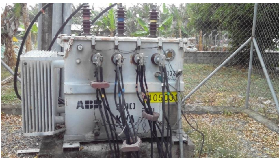
Ilustración 3.27 Transformador de piso en aceite de 13200/220 trifásico que alimenta todo el proceso de potabilización en la PPAP
