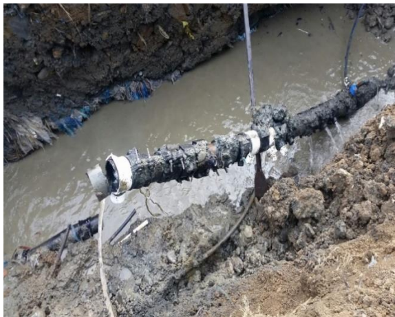
Ilustración 4.6 Tubería de 3 pulgadas de PEAD con conexiones ilegales
