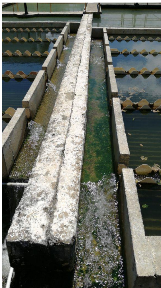
Ilustración 3.36 Cana de agua sedimentada
