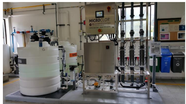
Ilustración 6.6 Sistema de hipo-cloración (generación de hipoclorito de sodio in-situ) ACUEDUCTO CALDAS – GRUPO EPM.
