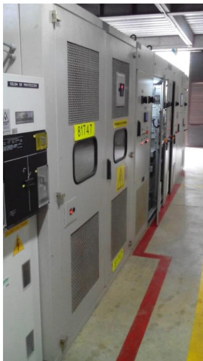
Ilustración 3.57 Tablero seccionador y transformador seco del sistema de bombeo a tanque bajo Casanova en PPAP.
