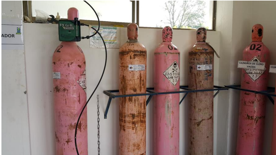
Ilustración 6.10 SISTEMA ANTERIOR con Uso de cloro gaseoso en formato de cilindros de 68kg.- EMPRESAS PÚBLICAS DE LA CEJA E.S.P.
