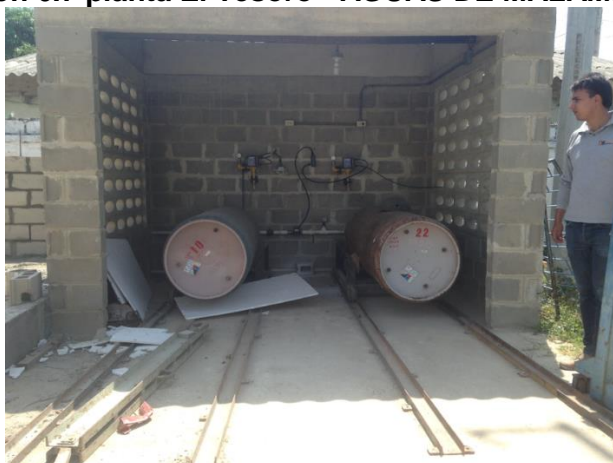
Ilustración 6.8 Sistema anterior con uso de cloro gaseoso en formato de cilindros de 1 Ton- AGUAS DE MALAMBO GRUPO EPM
