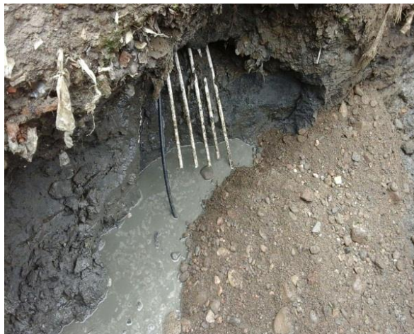
Ilustración 4.7 Flauta de conexiones ilegales
