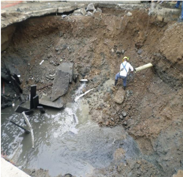
Ilustración 4.10 Hundimiento del terreno por socavación de fuga
