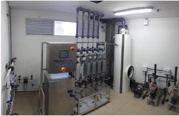
Ilustración 6.12 Nueva Planta de Tratamiento localizada en el Parque Natural Los Salados, Embalse La Fé y tecnología de producción de cloro in-situ - PLANTA VALLE SAN NICOLAS – GRUPO EPM
