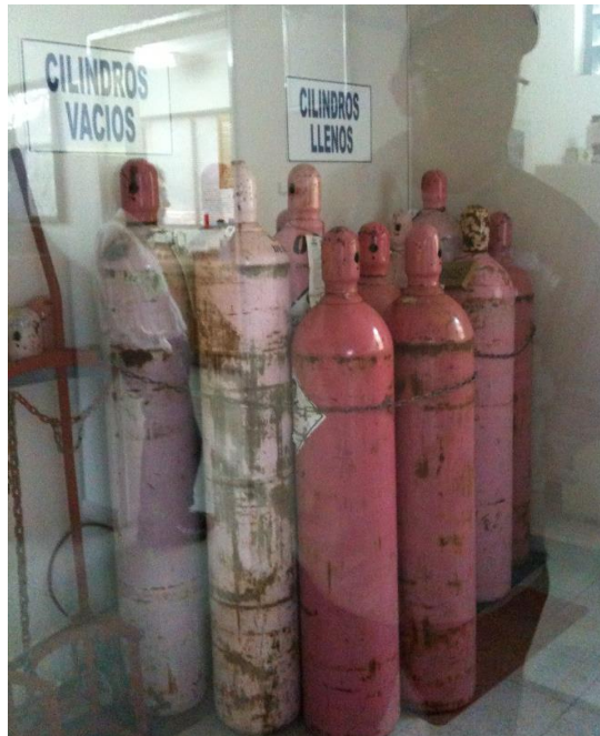
Ilustración 6.5 Uso de cloro gaseoso en formato de cilindros de 68kg ACUEDUCTO CALDAS – GRUPO EPM
