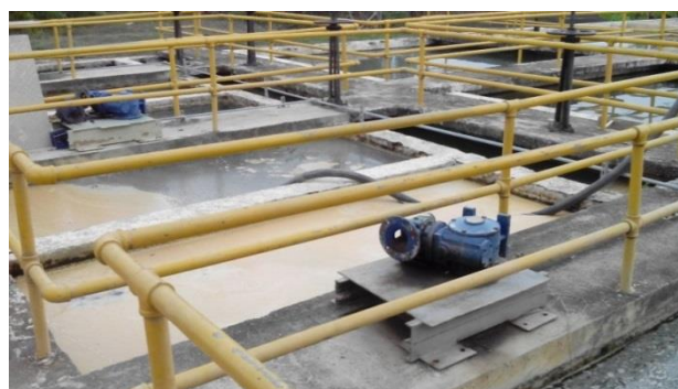
Ilustración 3.38 Motorreductores de sistema de floculación
