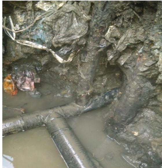
Ilustración 4.11 Conexión a tubería de PEAD con tubería en acero sin accesorio y con cimentación inadecuada (basura).
