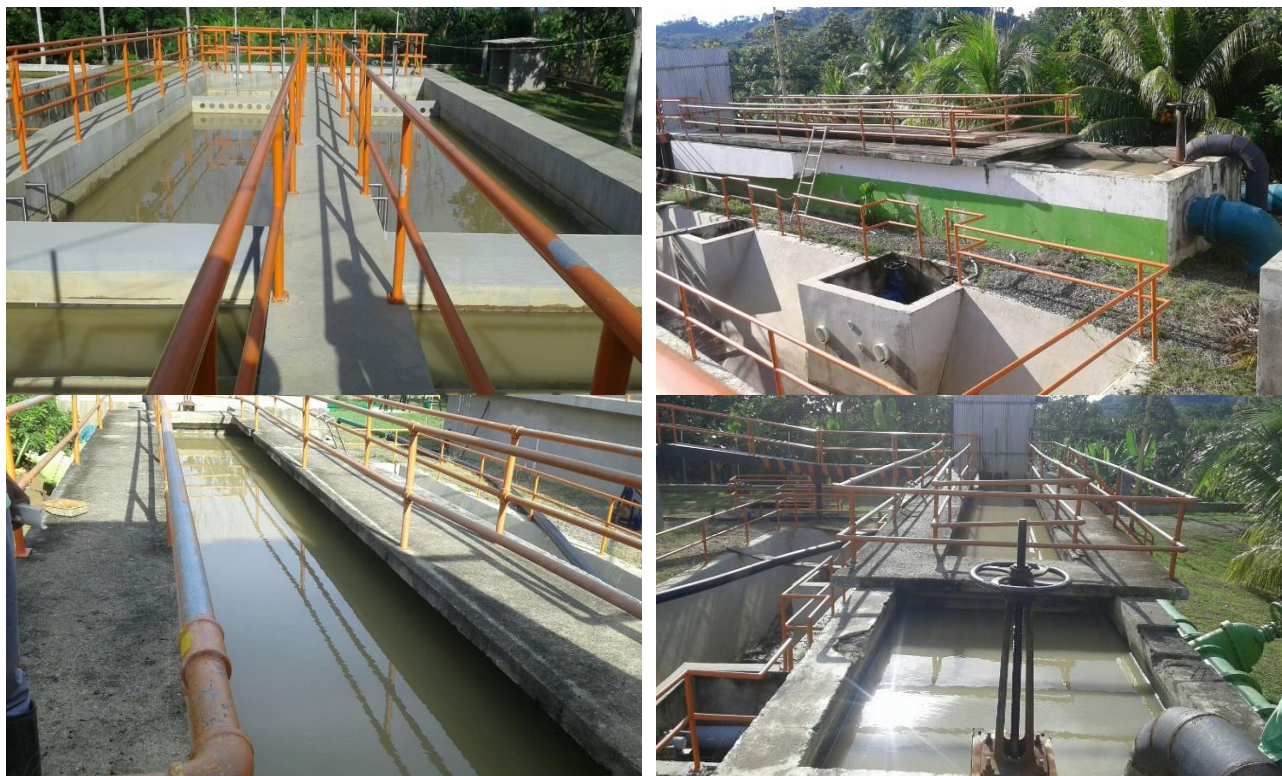
Ilustración 3.11 Desarenador nuevo capacidad 100 L/s
