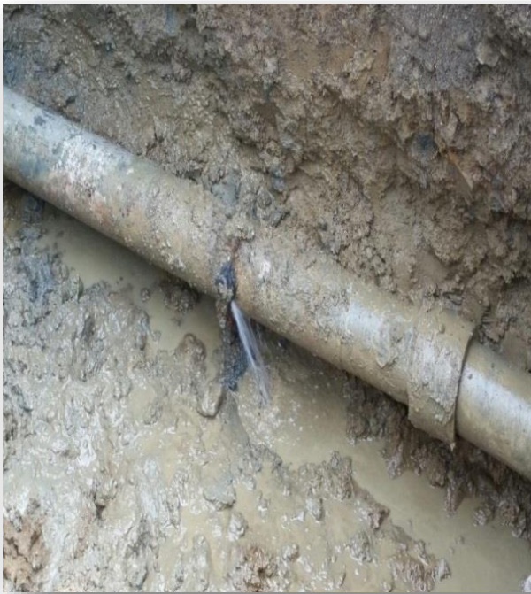
Ilustración 4.4 Tubería de asbesto cemento fracturada
