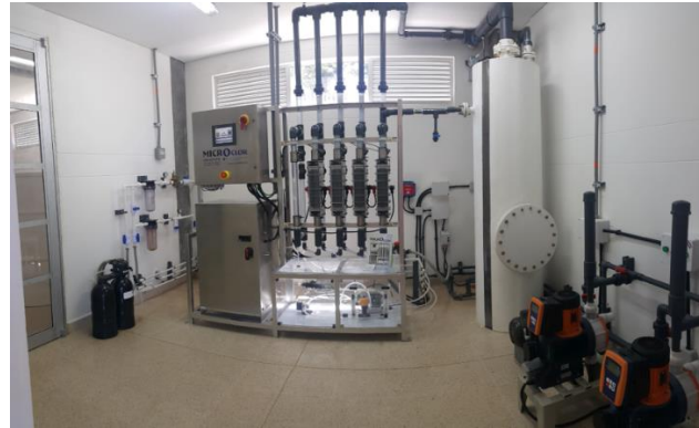
Ilustración 6.12 Nueva Planta de Tratamiento localizada en el Parque Natural Los Salados, Embalse La Fé y tecnología de producción de cloro in-situ - PLANTA VALLE SAN NICOLAS – GRUPO EPM
