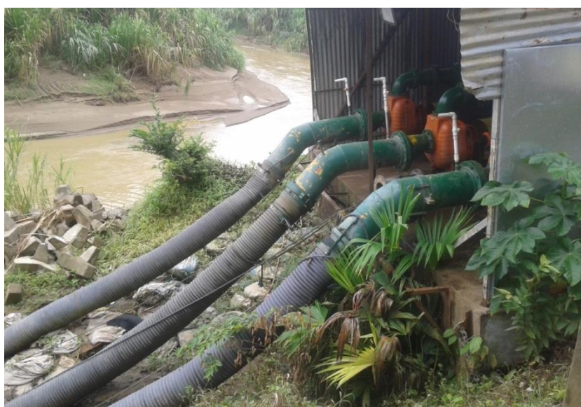
Ilustración 3.3 Bombeo de la captación en barcaza en épocas de verano
