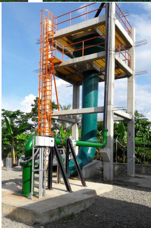
Ilustración 3.18 Pozo Salazar y Torre de aireación
