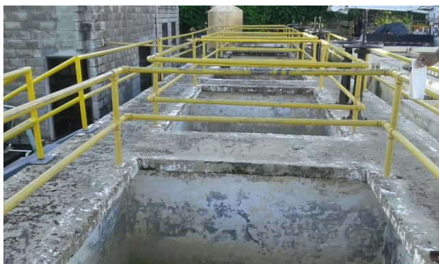
Ilustración 3.40 Filtros rápidos de flujo ascendente
