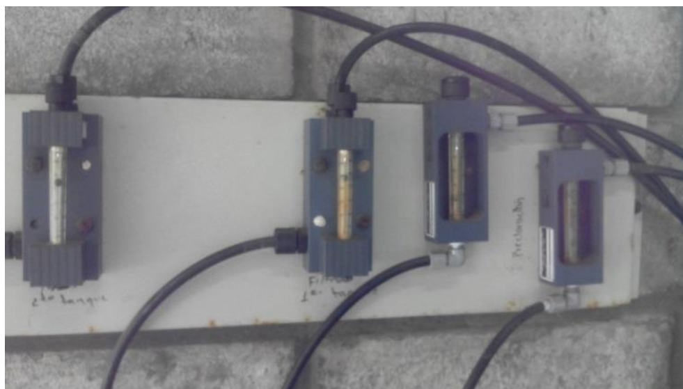
Ilustración 3.43 Rotámetros remotos para el sistema de pre cloración, cloración y post cloración.
