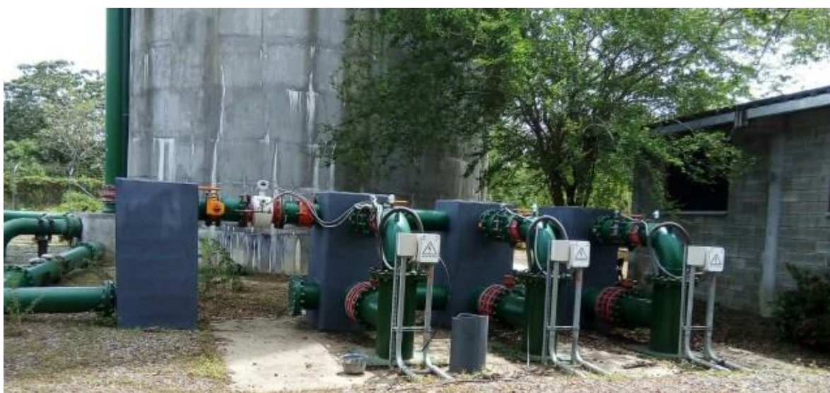
Ilustración 3.58 Bombes de pozo del sistema de distribución tanque Casanova.
