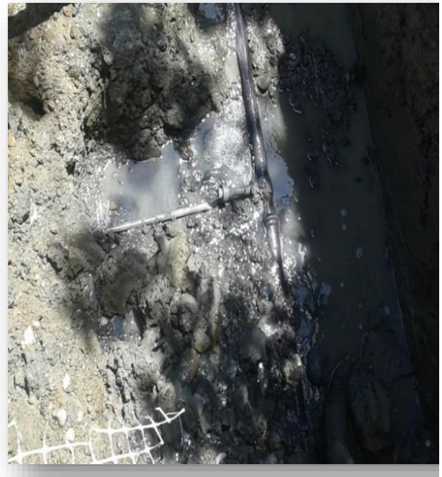
Ilustración 4.5 Tubería en PEAD de 2 pulgadas con conexión de 1 pulgada
