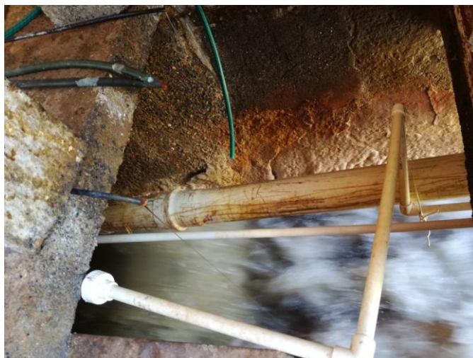
Ilustración 3.29 Canaleta Parshall y punto de aplicación de coagulante
