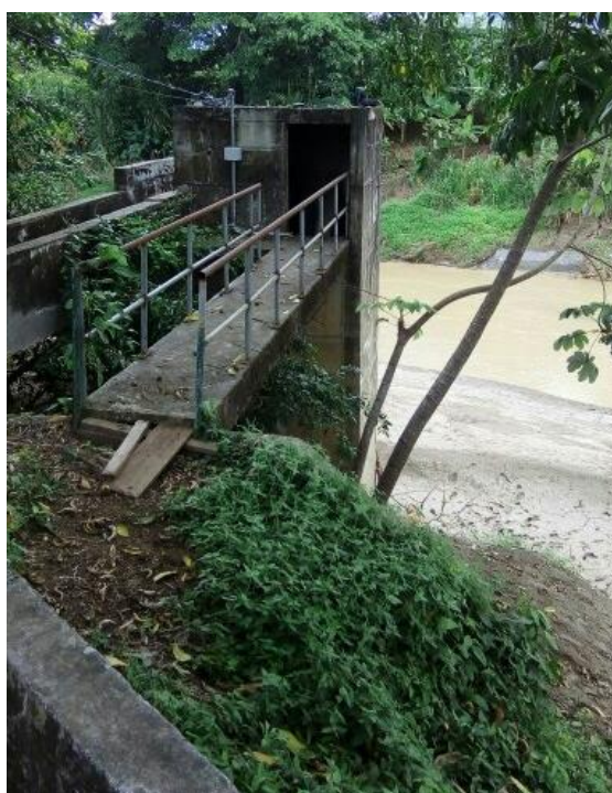
Ilustración 3.8 Torre de galería para equipo de bombeo sumergible.
