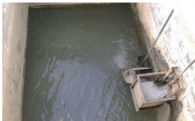
Ilustración 3.40 Filtros rápidos de flujo ascendente
