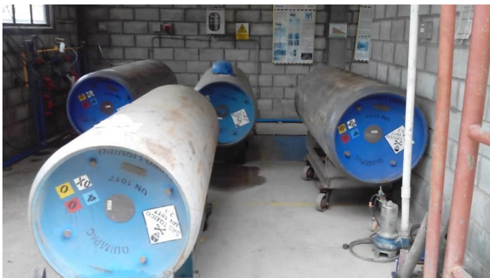
Ilustración 3.42 Cilindros de presión sistema de cloración.
