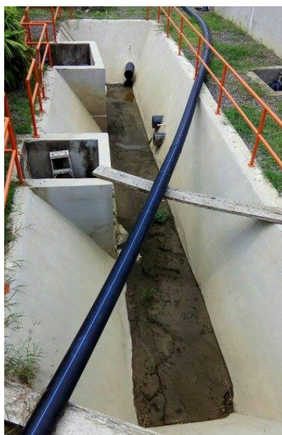
Ilustración 3.12 Lechos de secado del desarenador en la bocatoma del río Turbo.
