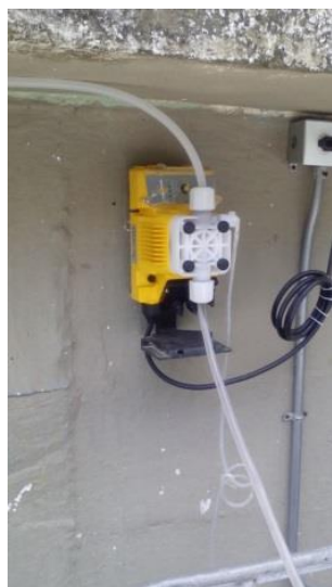
Ilustración 3.35 Instalación inicial de sistema de dosificación de soda caustica para estabilizar el pH
