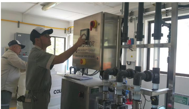
Ilustración 6.6 Sistema de hipo-cloración (generación de hipoclorito de sodio in-situ) ACUEDUCTO CALDAS – GRUPO EPM.
