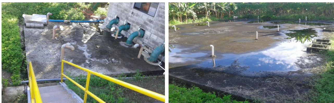
Ilustración 3.48 Tanques de 78 m 3 y 1500m 3 ubicados en la PPAP Villa Maria, abastecen tanque La Lucila y bombeo directo el Tancon
