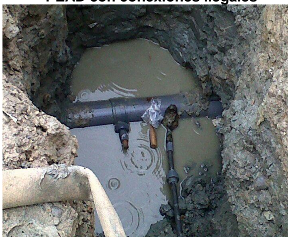
Ilustración 4.8 Conexiones ilegales
