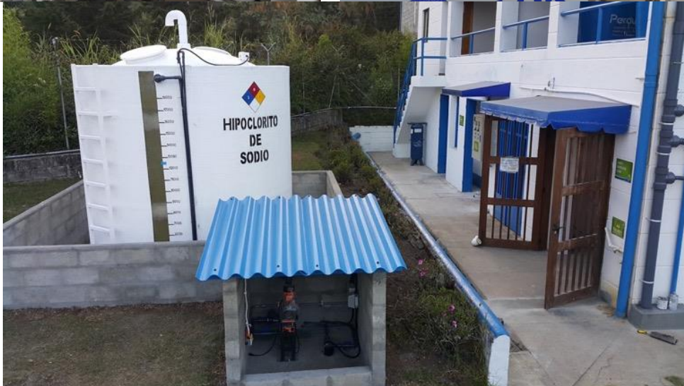
Ilustración 6.11 nuevo sistema uso microclor lc-40s, tanque de almacenamiento de cloro producido y sistema de aplicación. EMPRESAS PÚBLICAS DE LA CEJA E.S.P
