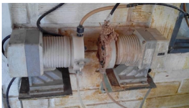
Ilustración 3.37 Motobombas de dosificación de policloruro y Sulfato de Aluminio
