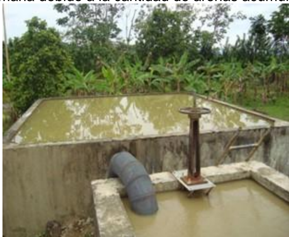
Ilustración 3.10 Desarenador existente
