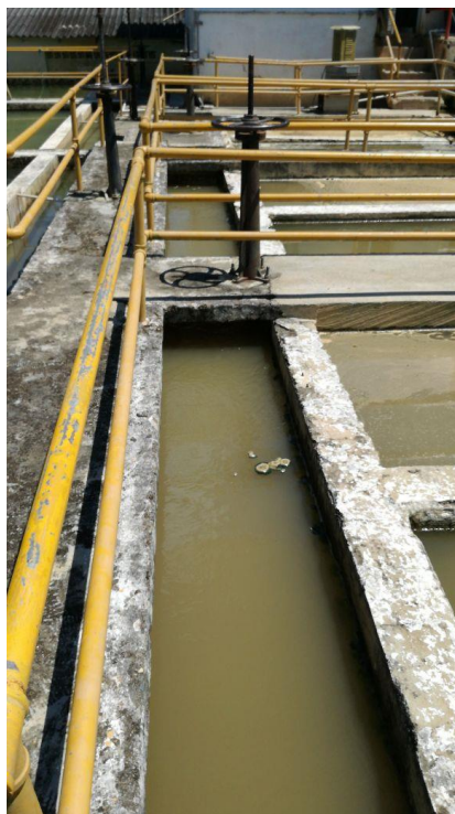
Ilustración 3.33 Canal de agua floculada
