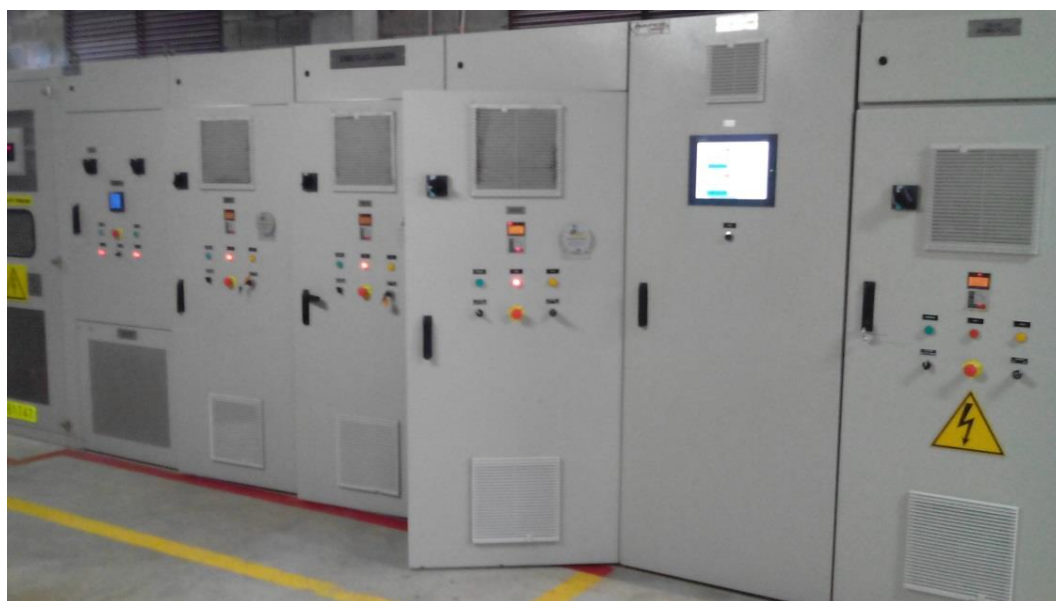
Ilustración 3.56 Tableros de control y potencia del sistema de bombeo a tanque bajo Casanova en PPAP
