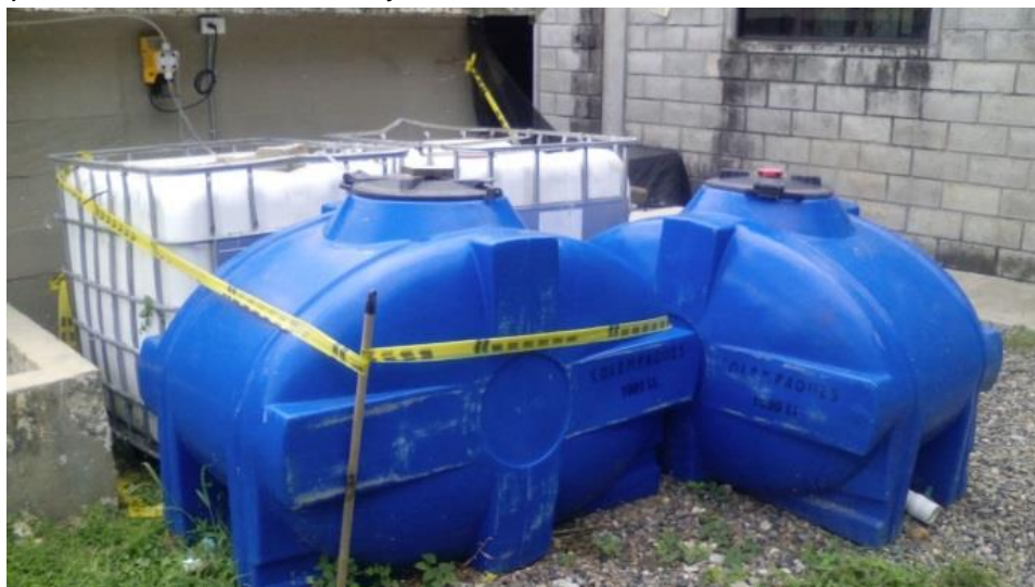
Ilustración 3.35 Instalación inicial de sistema de dosificación de soda caustica para estabilizar el pH
