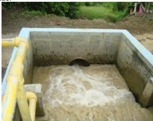
Ilustración 3.10 Desarenador existente
