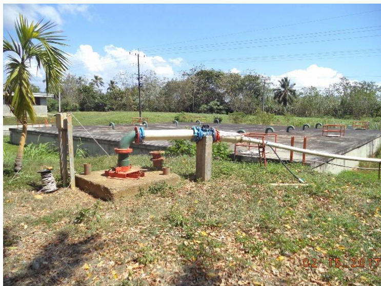
Ilustración 3.16 Sistema bombeo y aireación Pozo Villa Maria
