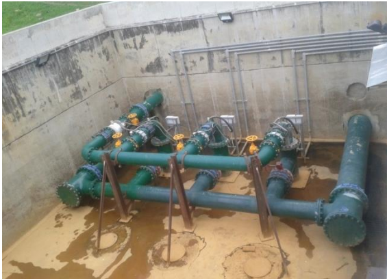
Figura 2.1a Sistema de bombeo a tanque bajo Casanova en PPAP (vista frontal-superior).
