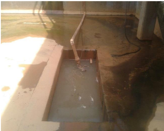
Figura 8.11a Pozo para bombeo sumergible de achique
