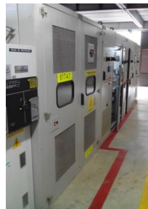
Figura 2.2a Tablero seccionador y transformador seco del sistema de bombeo a tanque bajo Casanova en PPAP
