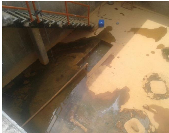
Figura 8.11b Pozo para bombeo sumergible de achique
