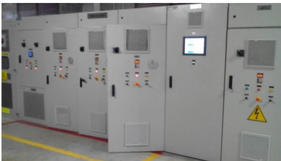
Figura 2.2a Tableros de control y potencia del sistema de bombeo a tanque bajo Casanova en PPAP
