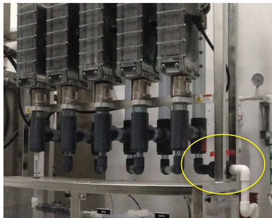
Figura 1 mostrando drenaje inferior de celdas electrolíticas
