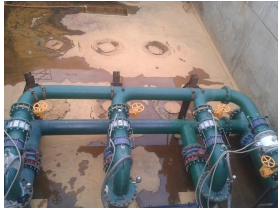
Figura 2.1b Sistema de bombeo a tanque bajo Casanova en PPAP (vista posterior-superior).
