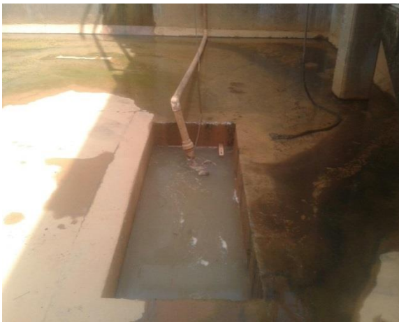
Figura 2.10a Pozo para bombeo sumergible de achique
