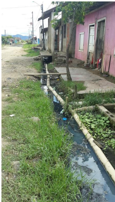
Agua residual a campo abierto, acometidas de acueducto expuestas y en riesgo permanente de contaminación
