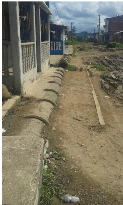
Agua residual a campo abierto, acometidas de acueducto expuestas y en riesgo permanente de contaminación
