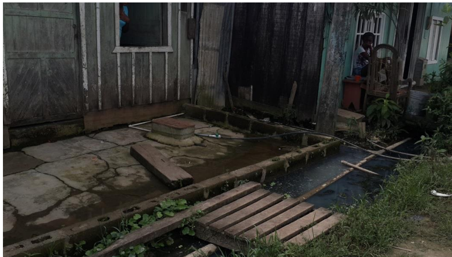
Agua residual a campo abierto, acometidas de acueducto expuestas y en riesgo permanente de contaminación
