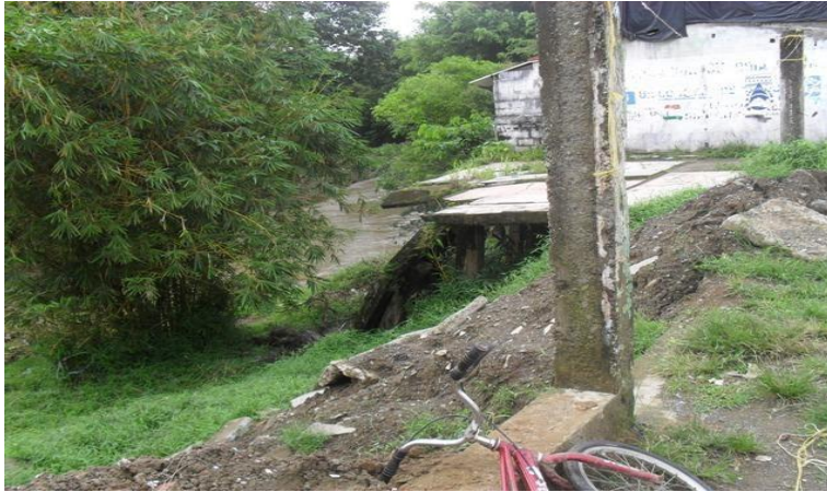
ILUSTRACIÓN 3. PROCESO DE SOCAVACIÓN Y EROSIÓN LATERAL, AFECTACIÓN DE VIVIENDAS BARRIO VLEZ
