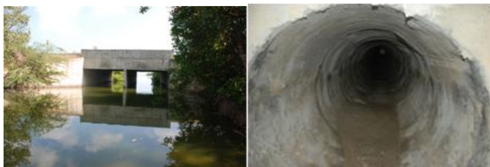
Figura 36. Box-coulverts y alcantarillas bajo la carretera Barranquilla - Ciénaga
